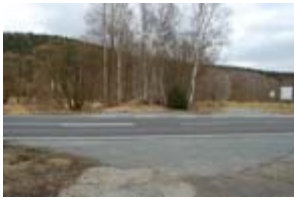
Bahndamm in der Elsteraue
